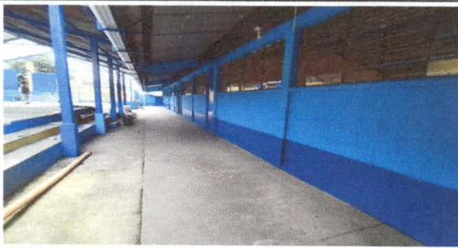
Foto 5: Sustitución de BAJANTE
