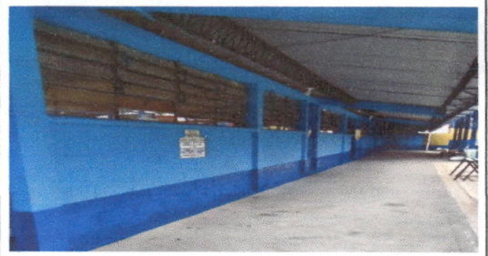
Foto 4: Sustitución de VIDRIOS
